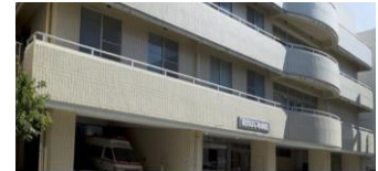
コロナ専門病院（横浜はじめ病院）外観
