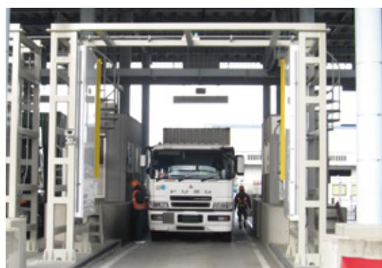
図8 据置型の放射線検知装置（整備中）
