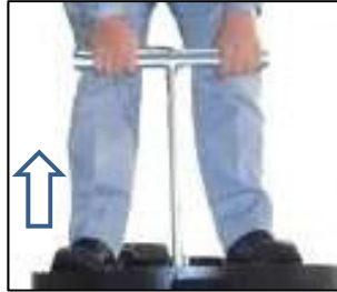
貯留弁引き上げ状況
