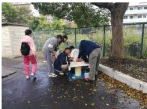
【下水道直結式トイレ設置訓練】
