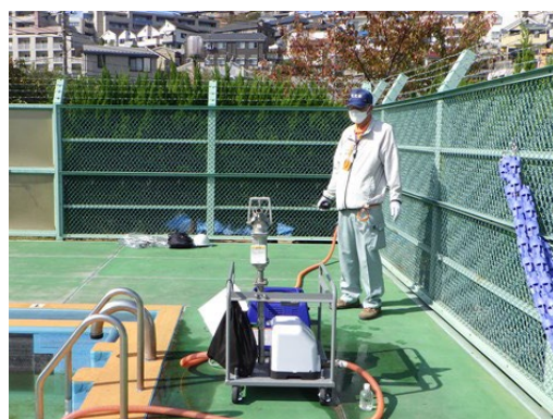
受水槽から応急給水
