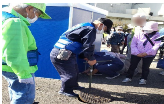
下水道マンホール蓋の開閉
