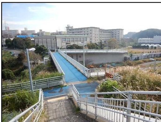
ひまわり歩道橋
