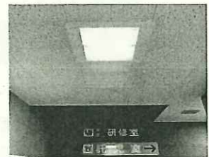
2階廊下のLED化
