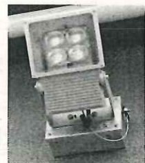
スポットライトの設置
