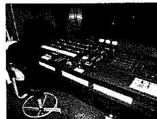
【照明調光卓/故障部品入手困難】
