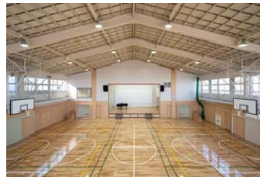
<体育館大規模改修事例>
