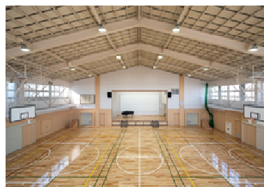
<体育館大規模改修事例>
