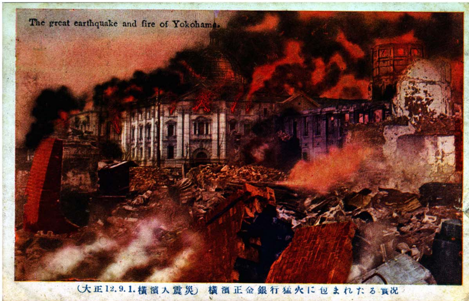
震災：絵葉書「(大正12.9.1.横濱大震災) 横浜正金銀行猛火に包まれたる実況 The great earthquake and fire of Yokohama.」
