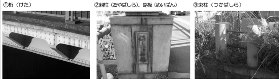
保土ヶ谷橋の現況
