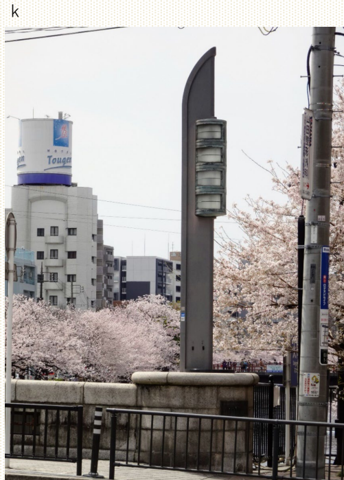
「刃」をモチーフとした高さ3mの立派な灯具がついた親柱である。
