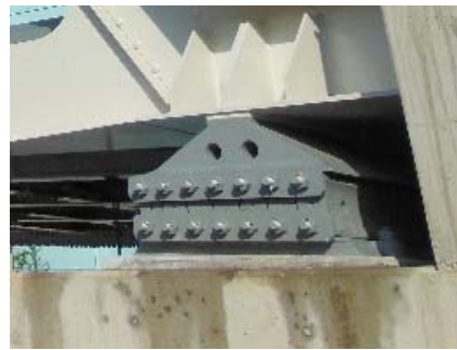
支承（再生後＋設置状況）
