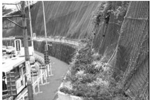
西区浅間下交差点付近の法面
