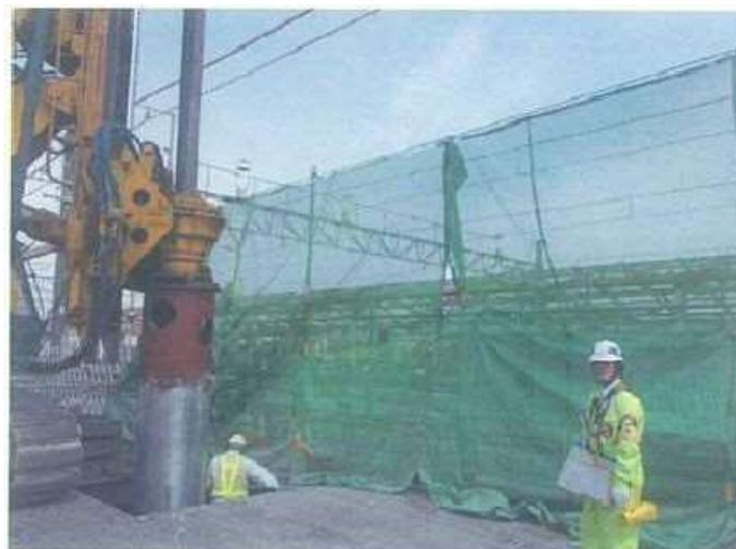
写真 4-3 環境保全のための措置の実施状況（工事現場での防塵ネット②）
