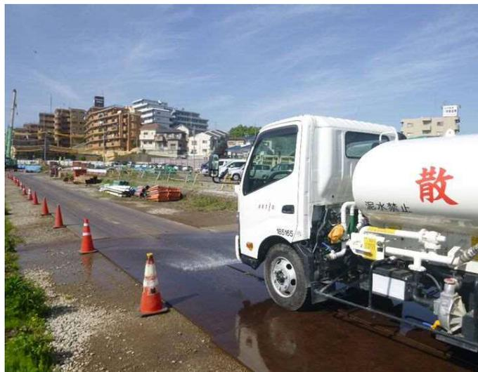
写真 4-2 環境保全のための措置の実施状況（工事現場での散水や清掃①）
