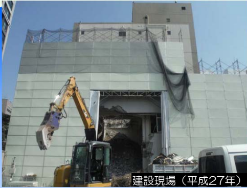
建設現場（平成27年）
