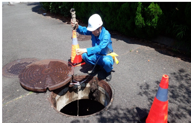
異常流入発生時の汚水管調査
