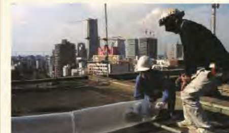
アスベスト除去作業の立入調査
