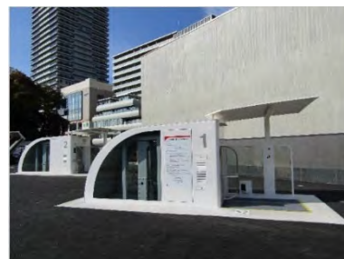
完成した地下機械式駐輪場（新綱島駅北口）
