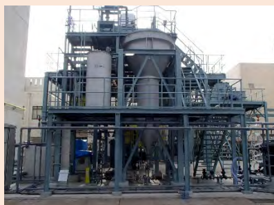
リン回収施設
