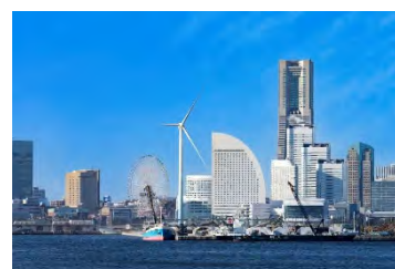
横浜市風力発電所（ハマウイング）
