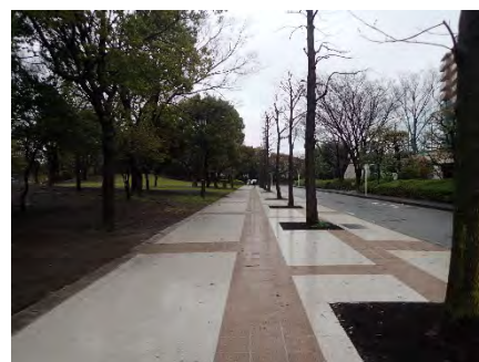
公園での透水性舗装等の整備による雨水の貯留・浸透機能の向上（中区）
