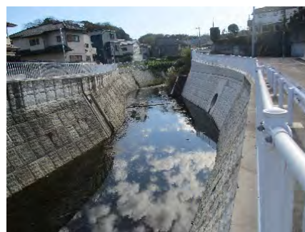
河川改修の状況（港南区）
