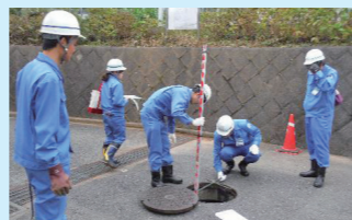
下水道管実地調査訓練
