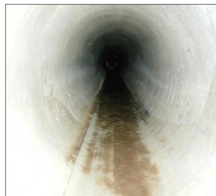
更生後の下水道管
