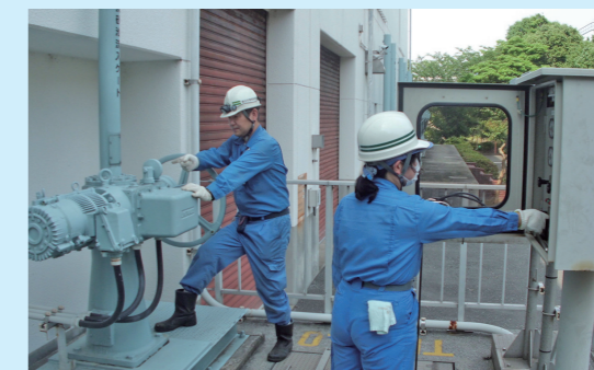
主要設備の点検 ゲート設備
