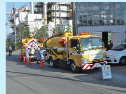
吸引車による下水道管の清掃
