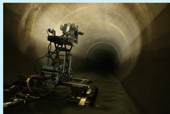
中大口径管の調査状況
