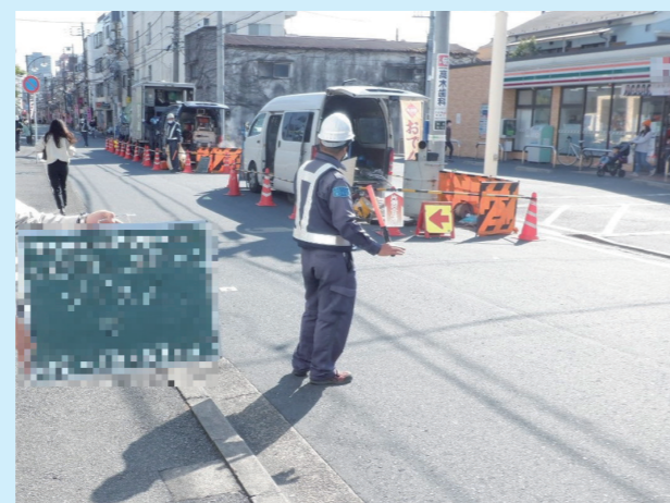
施工状況(形成工法)
