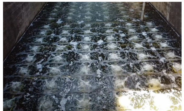
写真－5 反応タンク散気装置の発泡確認
