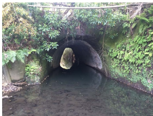
栄区 素掘りトンネル
