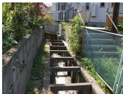
水路 (緑区 柵きょ形式の水路)
