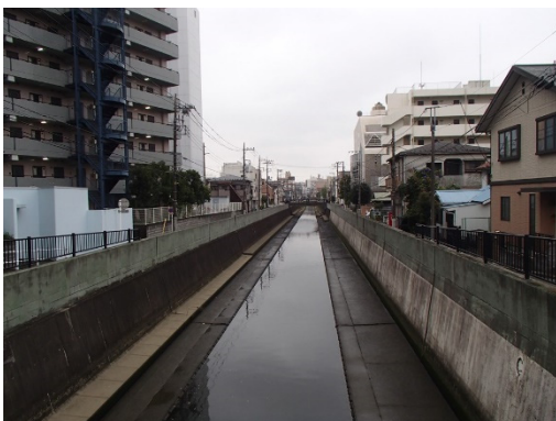
二級河川 今井川 (保土ヶ谷区)
