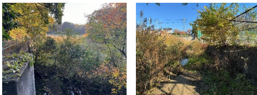
図 2-1 貯留機能が低下している施設
