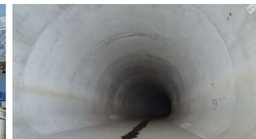
▲帷子川分水路のトンネル内部
