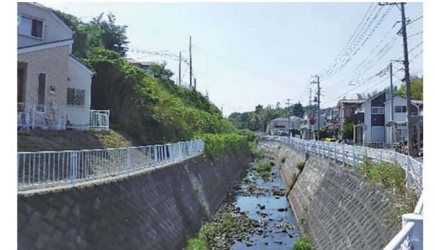
▲住宅地を流れる中堀川
