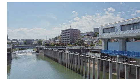
▲帷子川分水路入口
