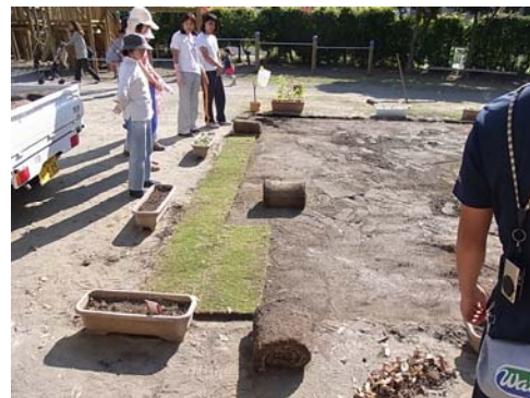
ロール状になった張芝の施工状況
