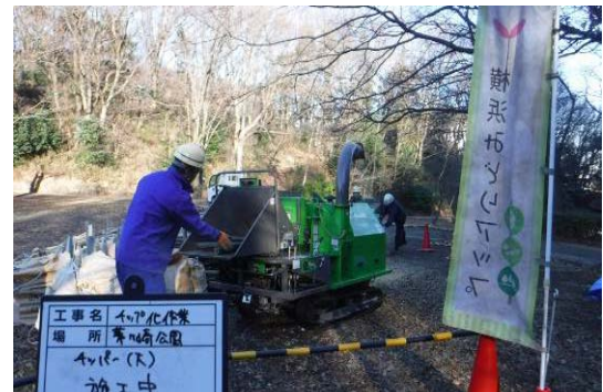
チップ化作業支援の様子(都筑区／茅ヶ崎公園)
