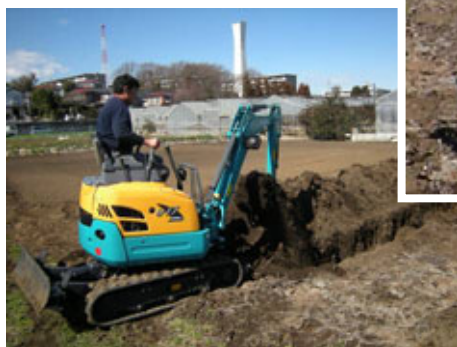
写真 リース方式により導入したバックホーによる、ゴボウの掘り取り作業の様子
