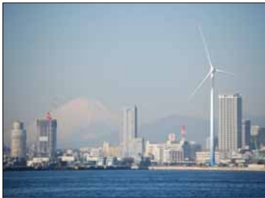
横浜市風力発電所（ハマウイング）
