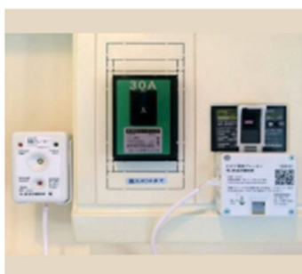
(左) 通電火災対策に有効な感震ブレーカー
