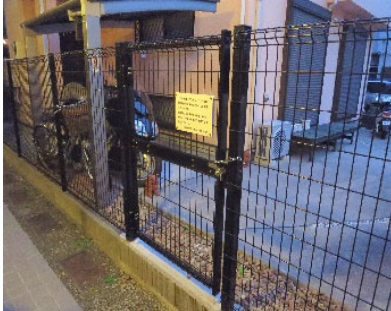
(左) 行き止まり解消のためにフェンスに設置した扉
