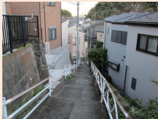
階段に沿って密集した建物
