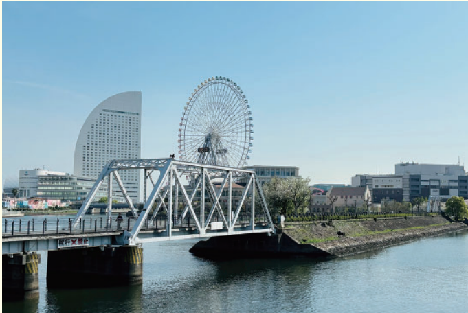
自動車道…新港ふ頭と現・桜木町駅（旧・横浜駅）を結ぶ貨物鉄道路線を生かしたプロムナード。平成9（1997）年完成。三つの橋梁及び二つの島の護岸が歴史的建造物として認定されている。プロムナード中の鉄道路線は当初から保全されているもの。
