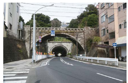
桜道橋（手前）と山手隧道（奥）
