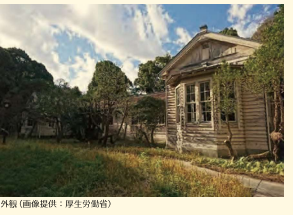
外観（画像提供：現生労働者）
