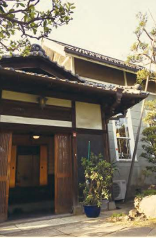
旧市原重治郎邸 主屋の奥に土蔵部
