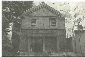
倉庫正面 扉は交換されている
