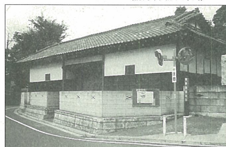
修復工事前の長屋門
