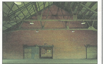
2号倉庫内部煉瓦大壁
