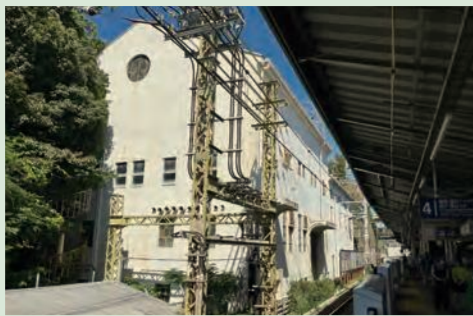
昭和4年建造の瀬戸変電所外観
