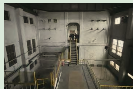
変電設備が収まっていた大空間
