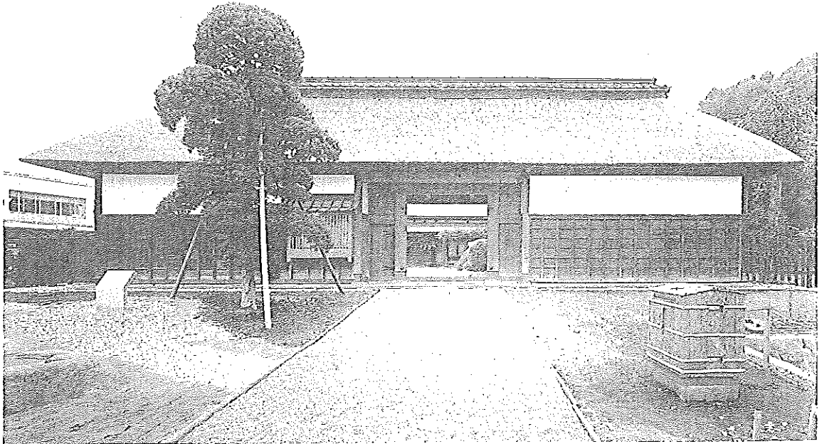
竣工 西面外観
