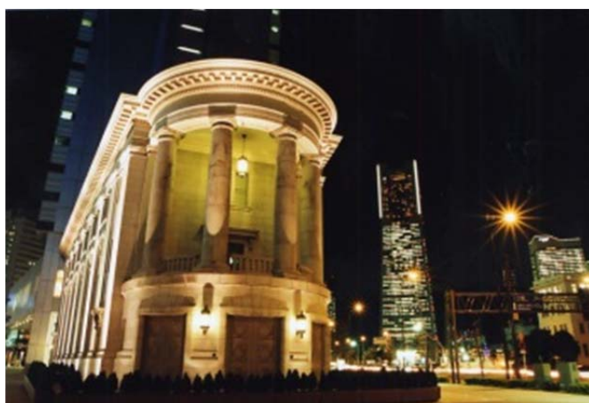
歴史的建造物のライトアップ
