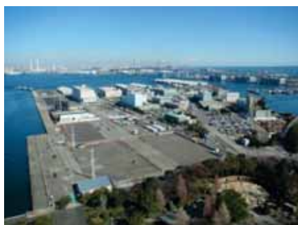
更地化の状況 令和2年1月
