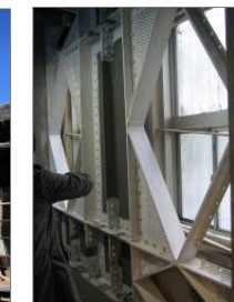
海洋会館 22 年度 耐震改修
