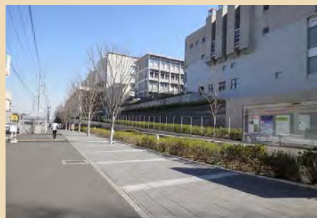
■敷地境界から後退し、樹木を植えることで、ゆとりと潤いのある空間を創出しています (港北区日吉／慶応義塾大学)
