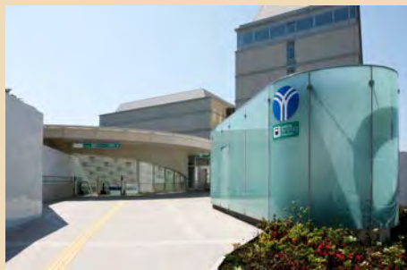
■学生の街の「動」と閑静な住宅街の「静」をモザイクタイルを用いて演出しています（港北区／市営地下鉄グリーンライン日吉駅）
