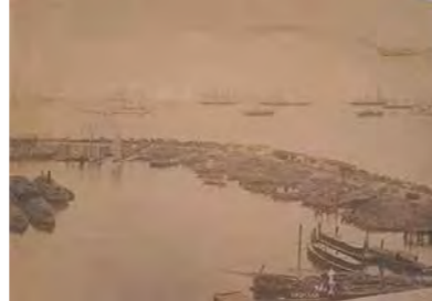
波止場改修工事で突堤を内側に湾曲させた形から「象の鼻」と呼称
