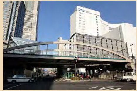
■彩度を抑えた色彩を用いることで、周囲の景観を阻害することなく調和しています（中区桜木町／みなとみらい4号線架道橋）
