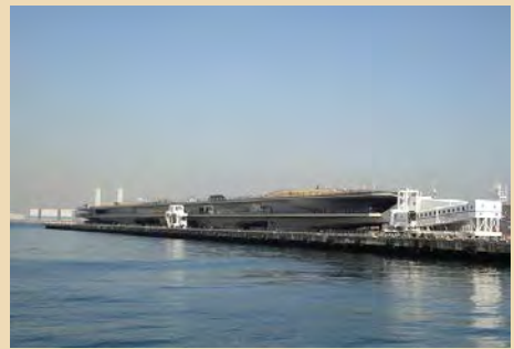
■ 先進的なデザインの採用により、港のランドマークとなっています（中区海岸通り／大さん橋国際客船ターミナル）
