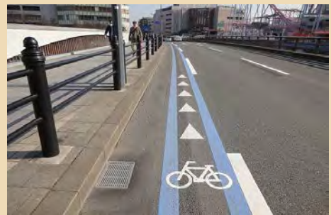
■ 自転車レーンに彩度を抑えた色を使用するとともに、塗装部分を必要最小限に抑えています (西区みなとみらい/国際橋)
