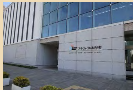
■ 外壁の低層部に石材を用いることで落ち着きを感じる外観となっています（青葉区あざみ野南／アートフォーラムあざみ野）
