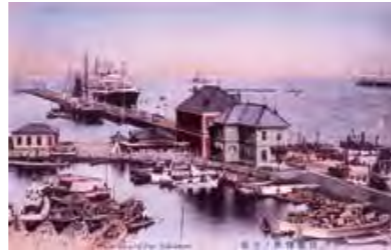
明治33〜43 (1900〜1910) 年頃横浜港第一期築港工事で完成した鉄棧橋（現大さん橋）（横浜みなと博物館所蔵）
