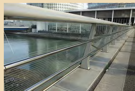
■ガラスと最小限の横棧でシンプルにデザインされた高欄が高質な街並みを演出しています（西区高島／はまみらいウォーク）
