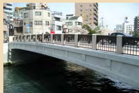
■装飾されていない桁側面が、高欄の意匠を引き立てています（中区黄金町／末吉橋）
