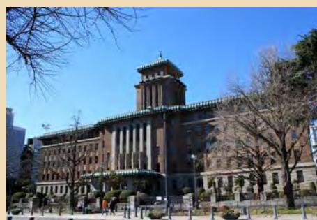
■歴史的建造物を保全、中央に立つ塔がアクセントとなっています (中区日本大通／神奈川県本庁舎)
