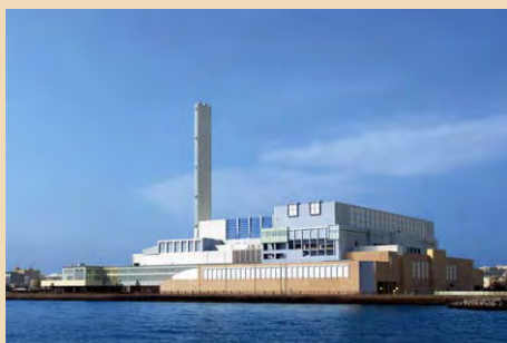
■ 建築物の外壁を彩度を抑えた色彩とすることで、海の青色と調和しています（金沢区幸浦／金沢工場（ごみ焼却工場））
