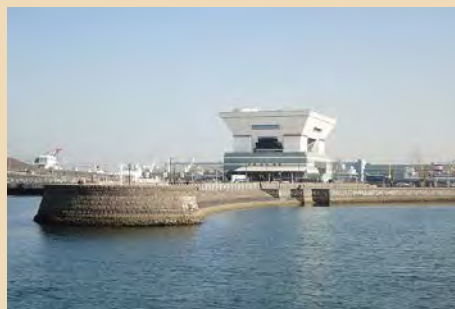
■ 石積護岸等の歴史的資産が保全されており、広場と一体となった景観を形成しています（中区海岸通り／象の鼻パーク）
