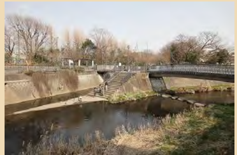
■ 堤防から水辺に降りる階段を整備し、水に触れあうことのできる空間が創出されています（栄区桂町／いたち川）
