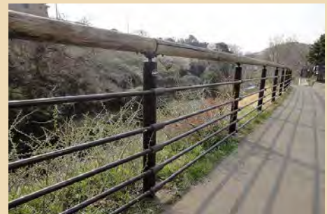
■ 柵に自然素材を用いることで、周辺の自然に馴染んでいます（栄区尾月／いたち川）
