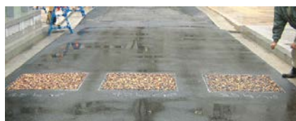
舗装骨材調整中の写真
