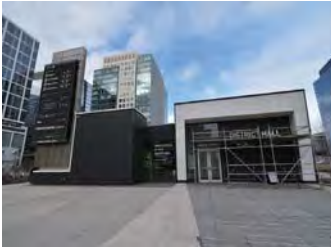
District hall (ボストン)
