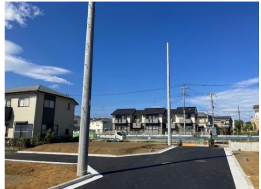
【宅地造成の様子】
