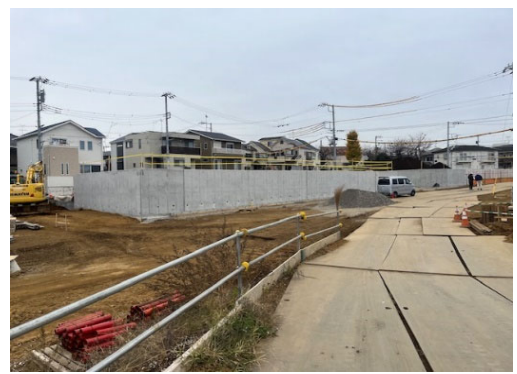
【宅地造成の様子】
