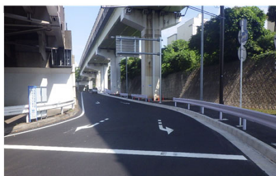
【③ 上川井IC出口 拡幅工事完成】
