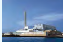
焼却工場(金沢工場)
