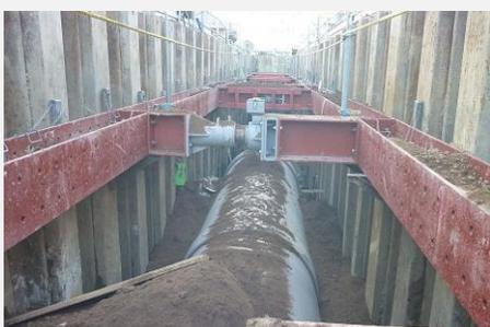
↑ 地下に下水道本管を入れています。(管径1.35m 延長65m)
