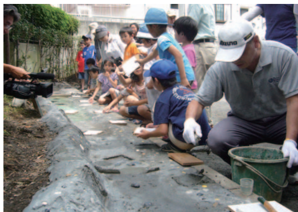
▲公園のせせらぎづくり(タイル張り作業)
