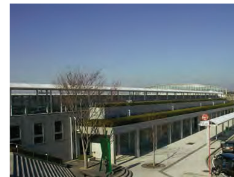
屋上緑化された駐輪場の例(石岡市)
