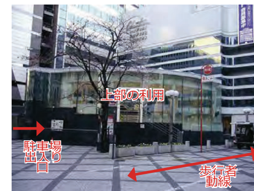
地下駐車場の出入口を歩行者のメイン動線を避けた配置としている例（千代田区）
