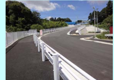
整備後の神奈川県菅田町地内道路(道路事業) 対面交通が可能になり、歩道整備により歩行者の通行の安全が確保された。
