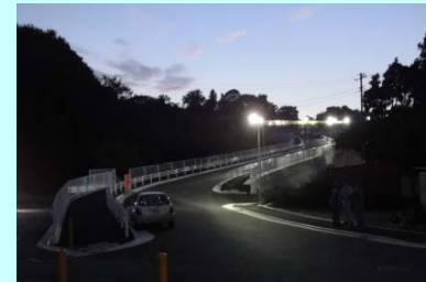
夜間時の神奈川県菅田町地内道路(道路事業) 外灯整備により夜間も安心して通行することが可能となった。
